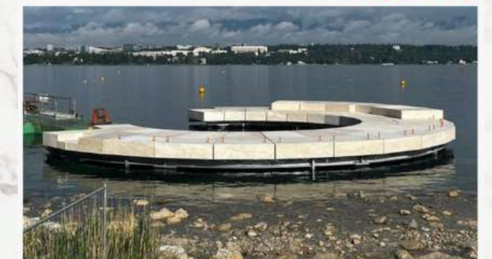
La piattaforma realizzata dalla «Pistore Marmi» a Colonia, sul Lago di Ginevra
